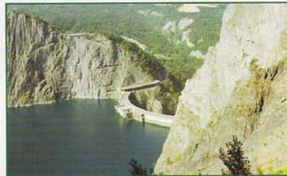
Vanuit de trein is het uitzicht schitterend. Hier een van de centrales in de bovenloop van de Drac.
